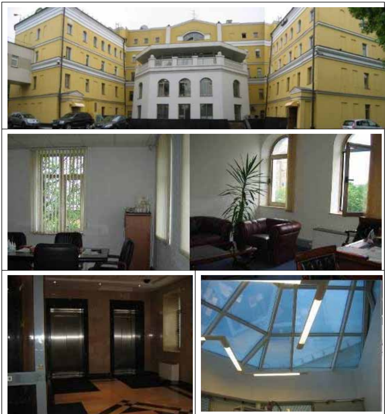
Рис. 15.2 Внешний вид здания ул. Погодинская, д.24, стр.1
