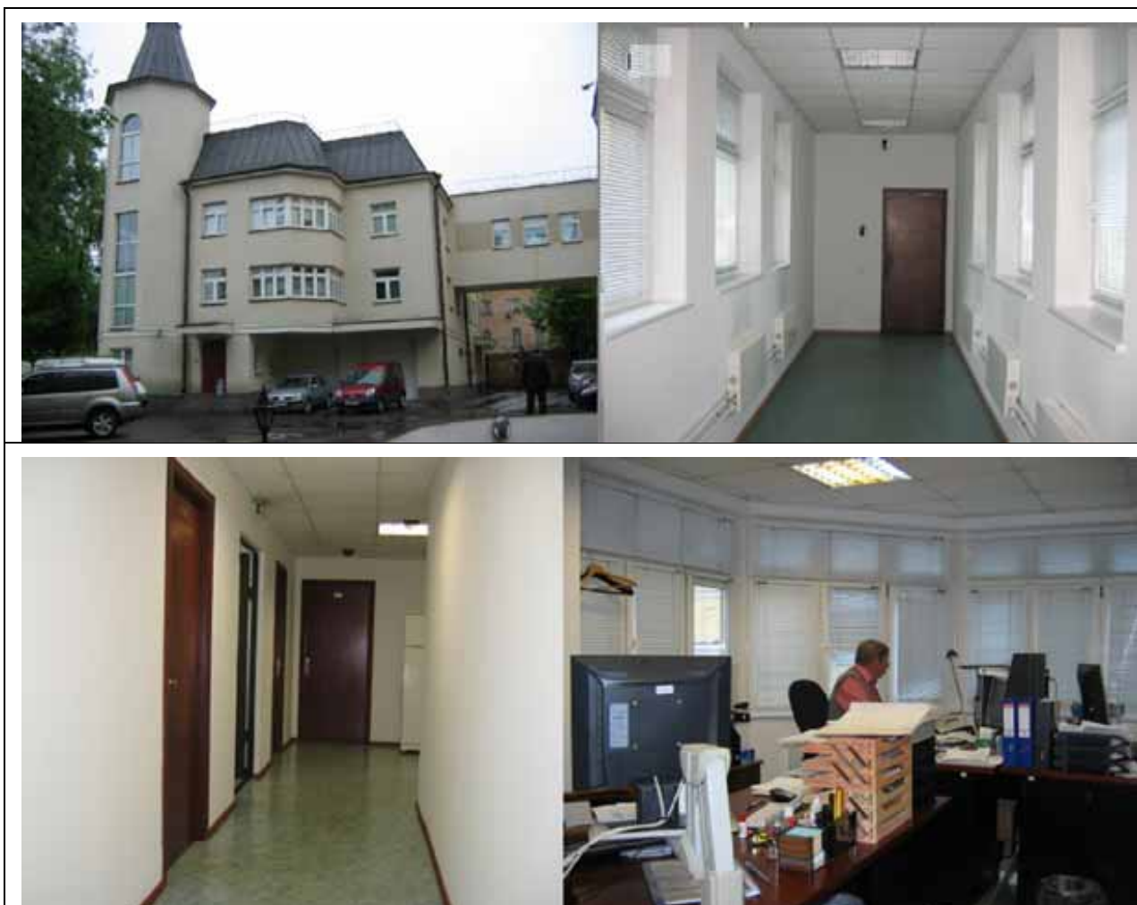
Рис. 15.3 Внешний вид здания ул. Погодинская, д.24, стр.2
